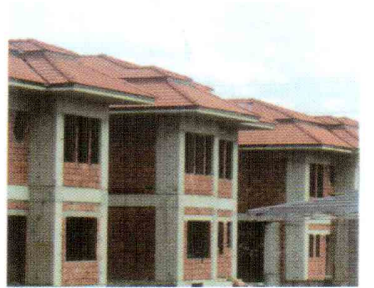
SUR İNŞAAT GREENIUM VİLLALARI
